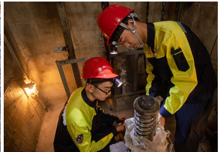
萬科物業維修人員正在進行電梯底坑精調維保
