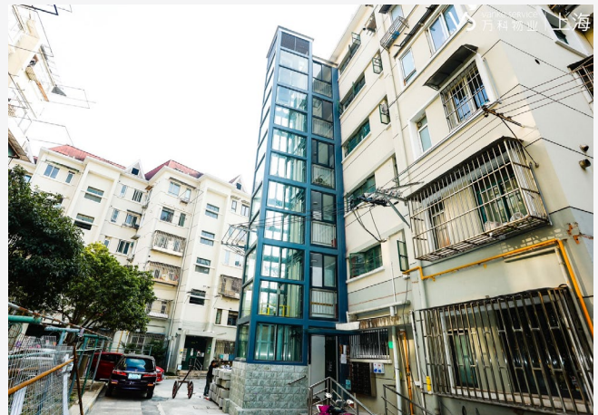
上海陽曲小區新加裝的電梯
